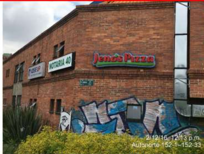
(Carrera 46 No. 152 – 46 – Sentido Sur - Norte)
