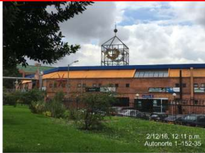
(Carrera 46 No. 152 – 46 – Sentido Sur - Norte)
